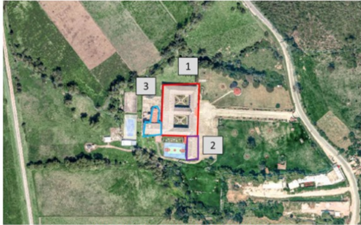
Localización general de las edificaciones principales
